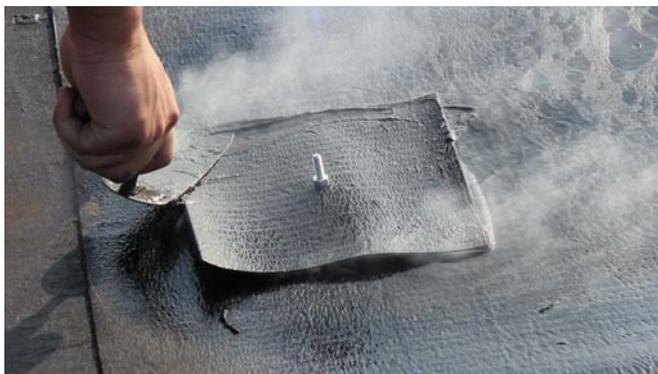
APPLICAZIONE TRAMITE FIAMMA DI UN PRIGIONIERO SU MANTO BITUMINOSO PER IL FISSAGGIO DELLA CANALA.
