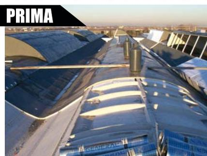
NUOVA COPERTURA PREFABBRICATA TRAVE-COPPELLA-SHED: IMPERMEABILIZZAZIONE CON ISOLAMENTO TERMICO
