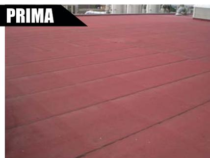
COPERTURA ESISTENTE CON MEMBRANA IMPERMEABILIZZANTE GRANIGLIATA A VISTA
