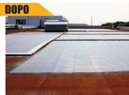
APPLICAZIONE DI GENERAL SOLAR PV SULLA COPERTURA ESISTENTE, SENZA FORATURE
