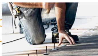
**Pegasus P:** Membrana monobitumata con armatura in poliestere e faccia inferiore in tessuto non tessuto di polipropilene. Strato di separazione per rifacimenti di stratigrafie in cui non è possibile effettuare una posa in totale aderenza.
