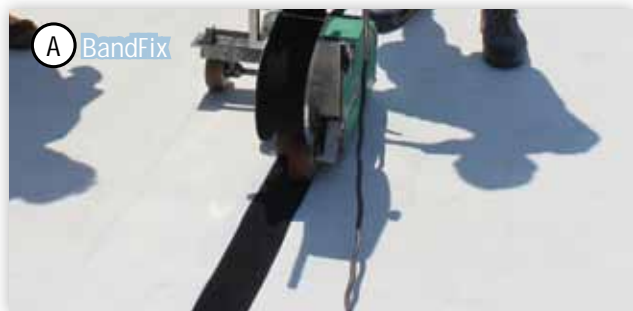
Posa di BandFix su manto sintetico.
