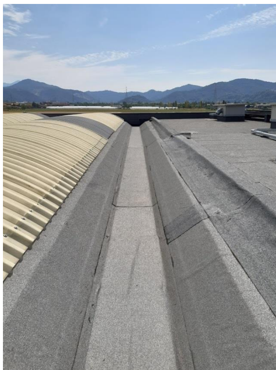
Fig. 32 – Copertura (oggetto visita ispettiva ITC) realizzata con doppio strato
