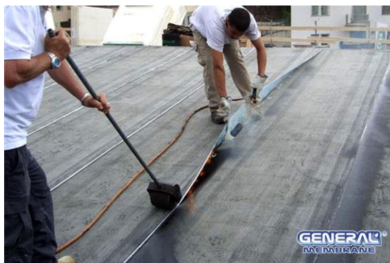
Fig. 9 – Tecnica di giunzione: Rullo
