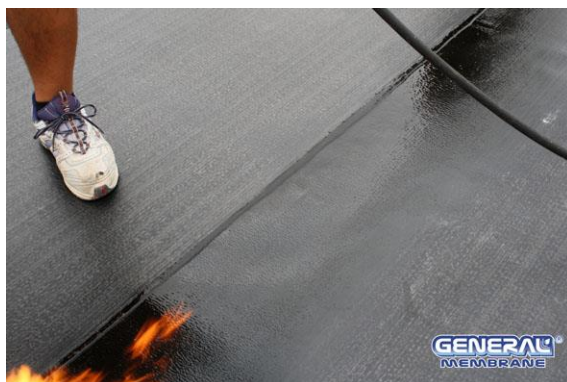
Fig. 10 – cordolo fuoriuscito dalla linea di sormonto
