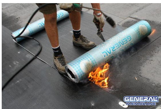
Fig. 11 – Tecnica di giunzione: Piede (vedere anche la figura del cordolo fuoriuscito da linea sormonto)
