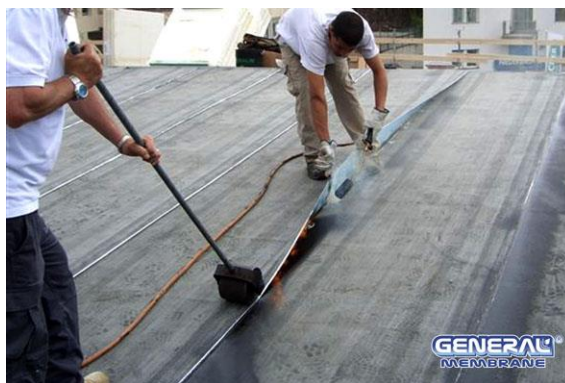
Fig. 12 – Tecnica di giunzione: Rullo (vedere anche la figura del cordolo fuoriuscito da linea di sormonto)
