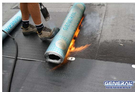
Fig. 3 - posa in totale aderenza su pannello isolante
