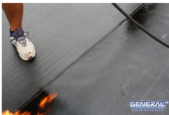
Fig. 13 – cordolo fuoriuscito dalla linea di sormonto
