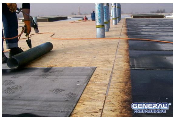
Fig. 2 - posa in totale aderenza su supporto ligneo
