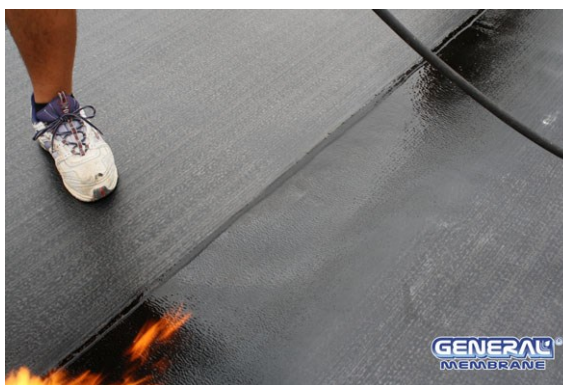
Fig. 14 – cordolo fuoriuscito dalla linea di sormonto
