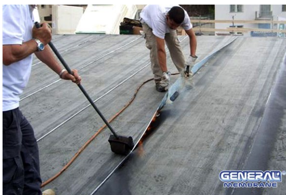
Fig. 13 – Tecnica di giunzione: Rullo (vedere anche la figura del cordolo fuoriuscito da linea di sormonto)
