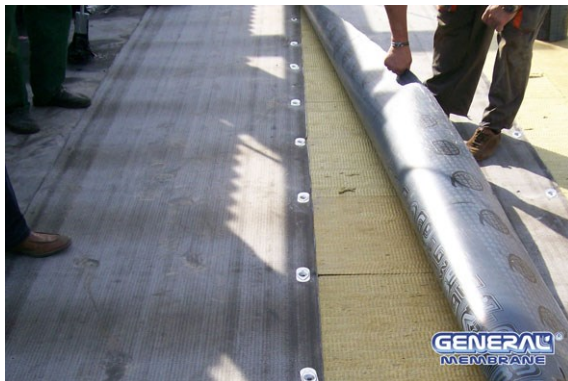
Fig. 7 - posa con fissaggio meccanico per punti, Tetto Caldo
