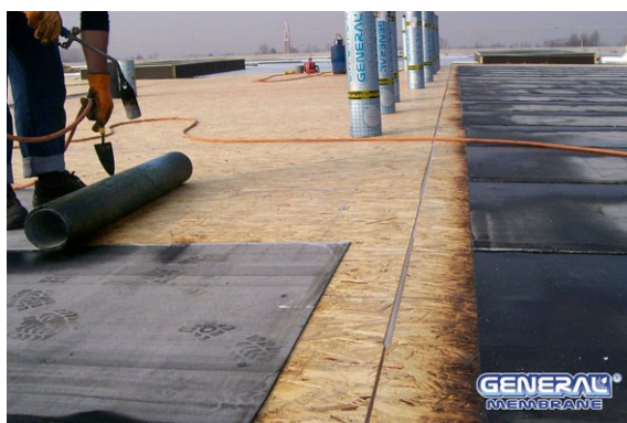
Fig. 3 - posa in totale aderenza su supporto ligneo
