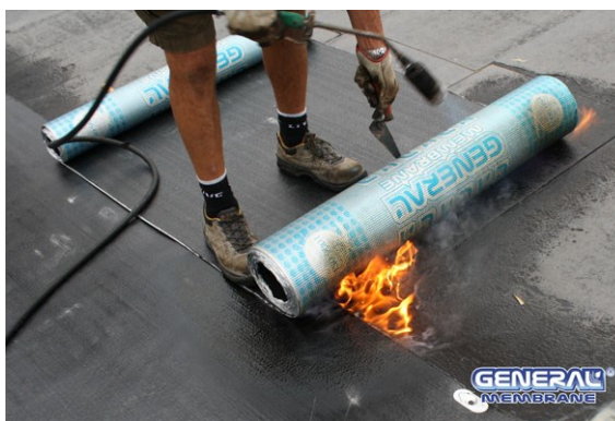
Fig. 12 – Tecnica di giunzione: Piede (vedere anche la figura del cordolo fuoriuscito da linea sormonto)
