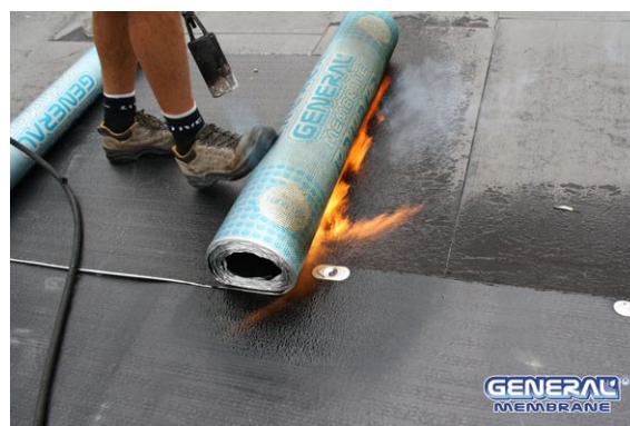
Fig. 4 - posa in totale aderenza su pannello isolante
