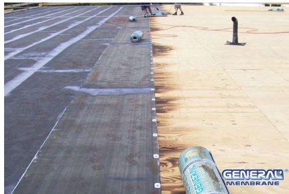
Fig. 8 - posa con fissaggio meccanico per punti su legno
